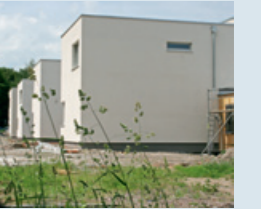
Gerade fertig geworden sind Wärmeschutz- und Fassadenarbeiten.
