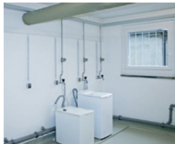
Im Keller werden zentrale Waschküchen eingerichtet und auch die langen Flure erstrahlen demnächst neu.
