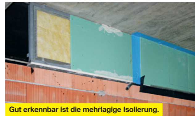
Hinter der Wand verbirgt sich ein isolierter Pfeiler des Hochgleitstragwerks.
