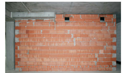
Hinter der Wand verbirgt sich ein isolierter Pfeiler des Hochgleitstragwerks.
