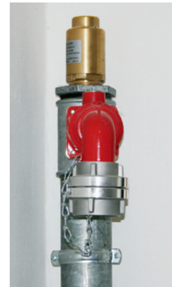
Endstück einer Steigleitung für Löschwasser
