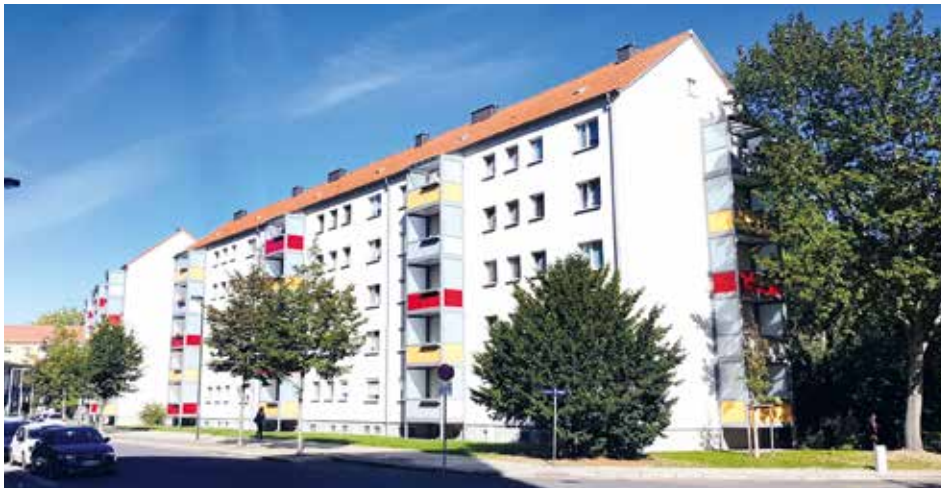
Sanierte Fassaden mit Vollwärmeschutz und Anstellbalkone in der Dresdner Josephinenstraße
