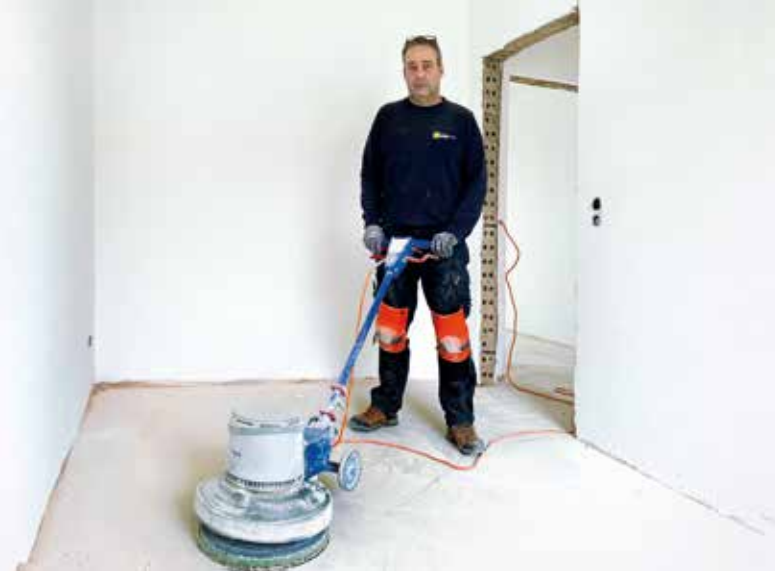
Vorbereitung für die Verlegearbeiten des neuen PVC-Belages
