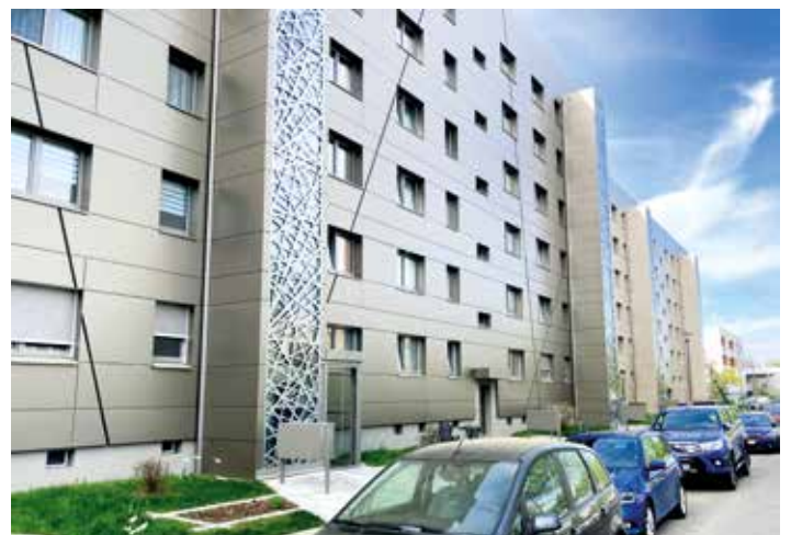
Auch so kann WBS 70 aussehen: frisch sanierte und gestaltete Fassaden mit vorgesetzten Fahrstuhlanbauten
